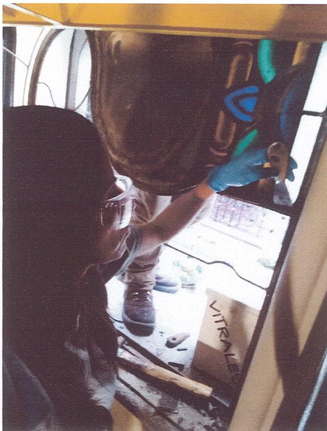
**TOMA DE FOTOGRAFÍAS, MEDICIÓN Y REALIZACIÓN DE FICHA DE REGISTRO DE LOS DAÑOS A CADA PANEL DEL VITRAL.**
